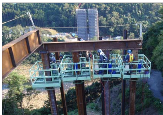
写真6 KOSMOS ゴンドラ工法施工状況
