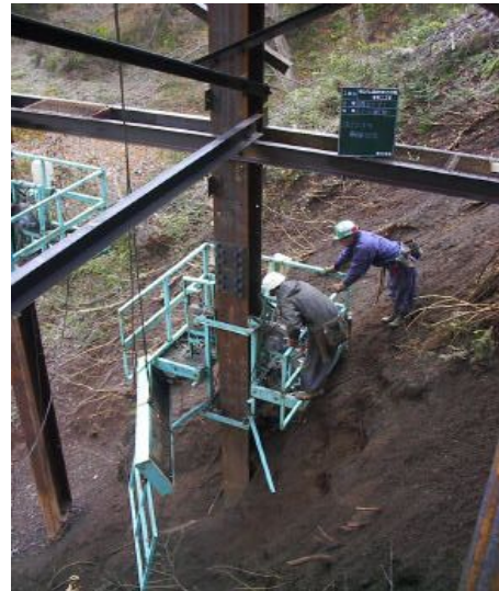
写真－6 足場用ゴンドラ撤去作業
