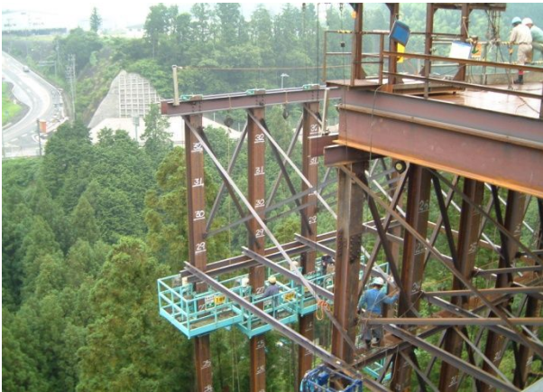
写真－5 足場用ゴンドラ作業風景
