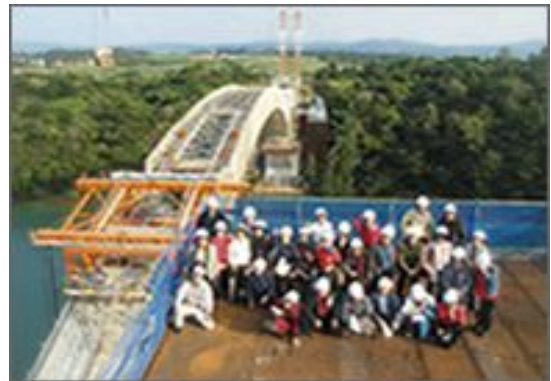
写真-8 仮栈橋上での見学会風景
