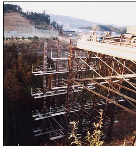
写真－３ 従来方式の足場（作業床）
