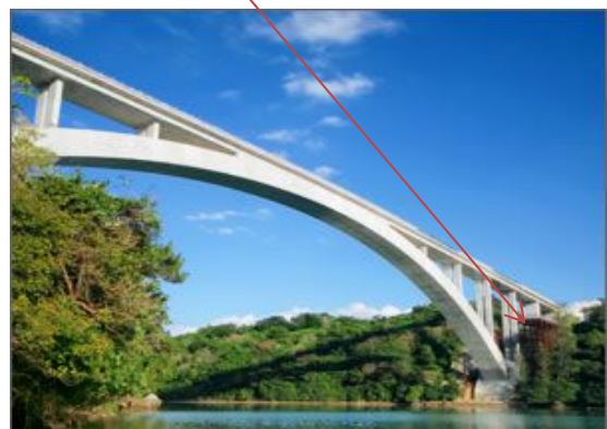
写真-9 ワルミ大橋工事中の全景
