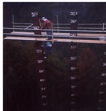
写真－４ 作業員の昇降作業
