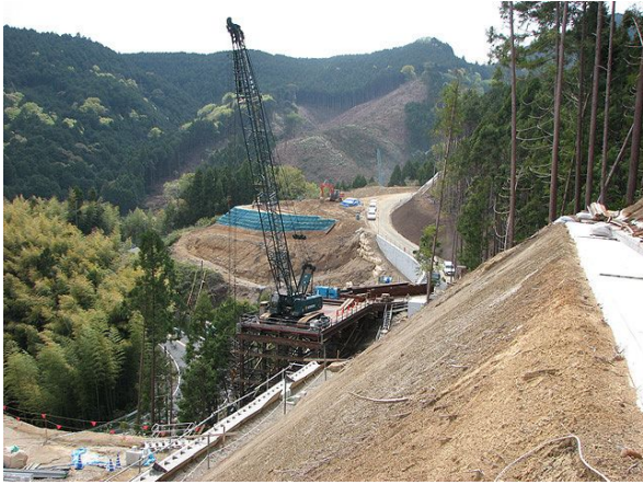
写真－２ 仮栈橋工事
