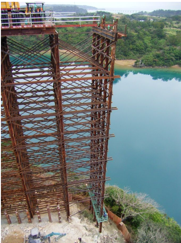
写真-7 2005年施工・ワルミ大橋
