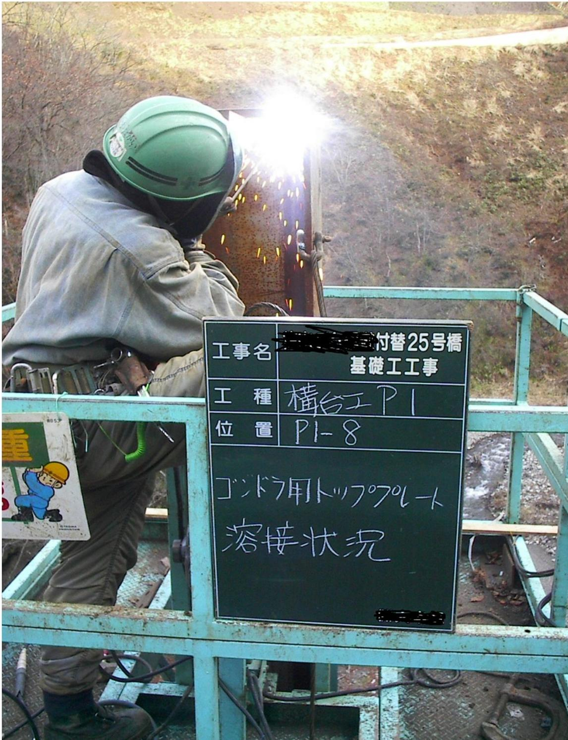
☆ 溶接完了後に、ゴンドラの吊りワイヤー端部を吊り治具に取付て完了となる。
