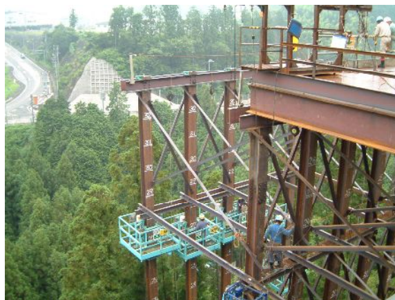
写真2 ゴンドラ内で作業が可能（足場用ゴンドラ作業風景）
